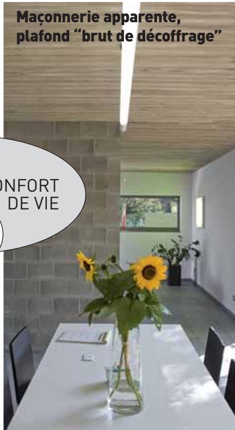
Sol lissé, escalier et plafond sans finition
